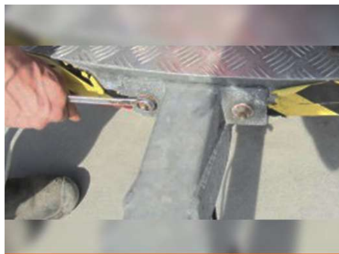
4. Draai de bouten en die moeren die u heeft bewaard, weer vast
